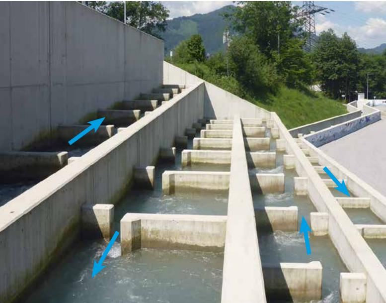
Ein **Schlitzpass** ist eine technische, aber wirkungsvolle Maßnahme, um den Fischen die Passage über Wehranlagen zu ermöglichen. Pfeile: Wanderrichtung der Fische
