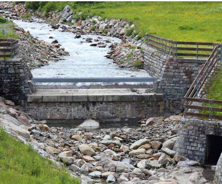
Bei alten Wasserrechten, vor allem im Bereich von Speicherseen, gibt es oft nach wie vor keine Restwasserregelung. Der Bach im Bild fällt unterhalb der Fassung trocken. Eine Nachjustierung ist in den nächsten Jahren zu erwarten (Wasserrahmenrichtlinie der EU).
