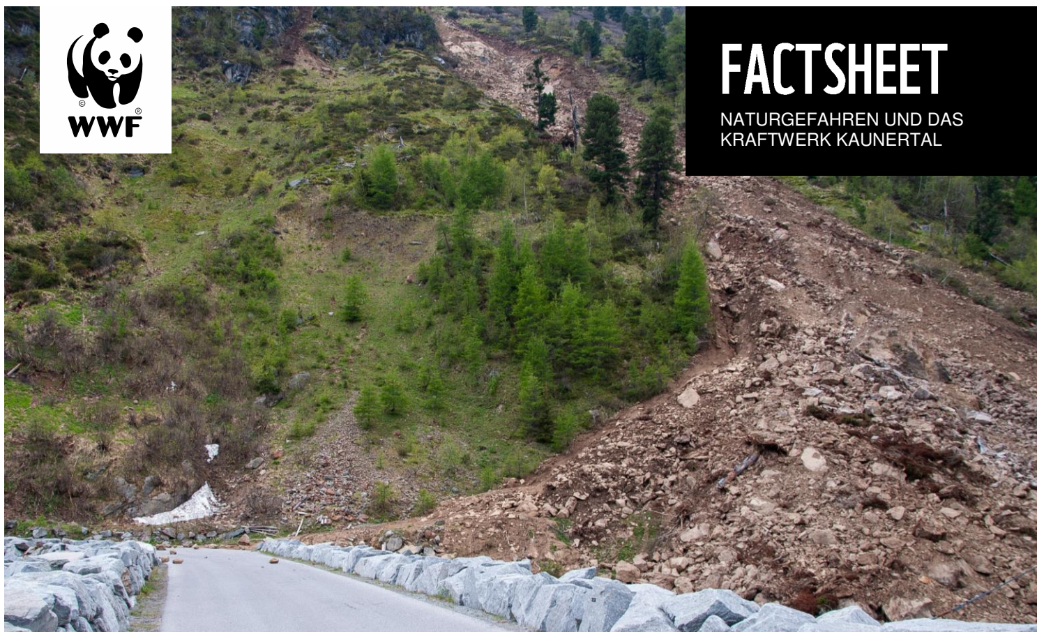
Hangrutschung am Gepatschspeichersee im Kaunertal © Christoph Praxmarer
